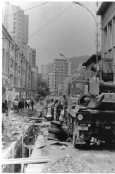
Радови на цевоводу кроз главну улицу
