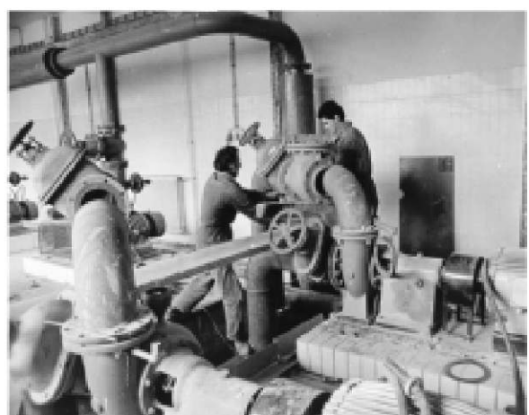
Монтирање опреме на постројењу
