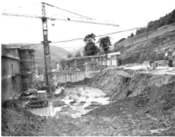
Изградња постројења на Церовића Брду
