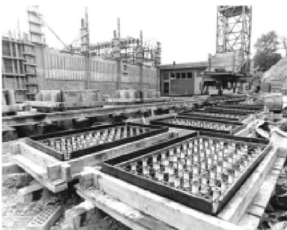
Радови на изградњи постројења
