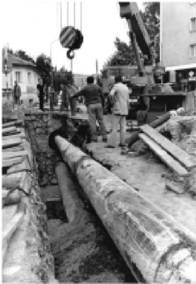
Изградња цевовода кроз град
