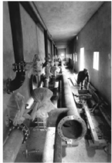
Монтирање опреме на постројењу
