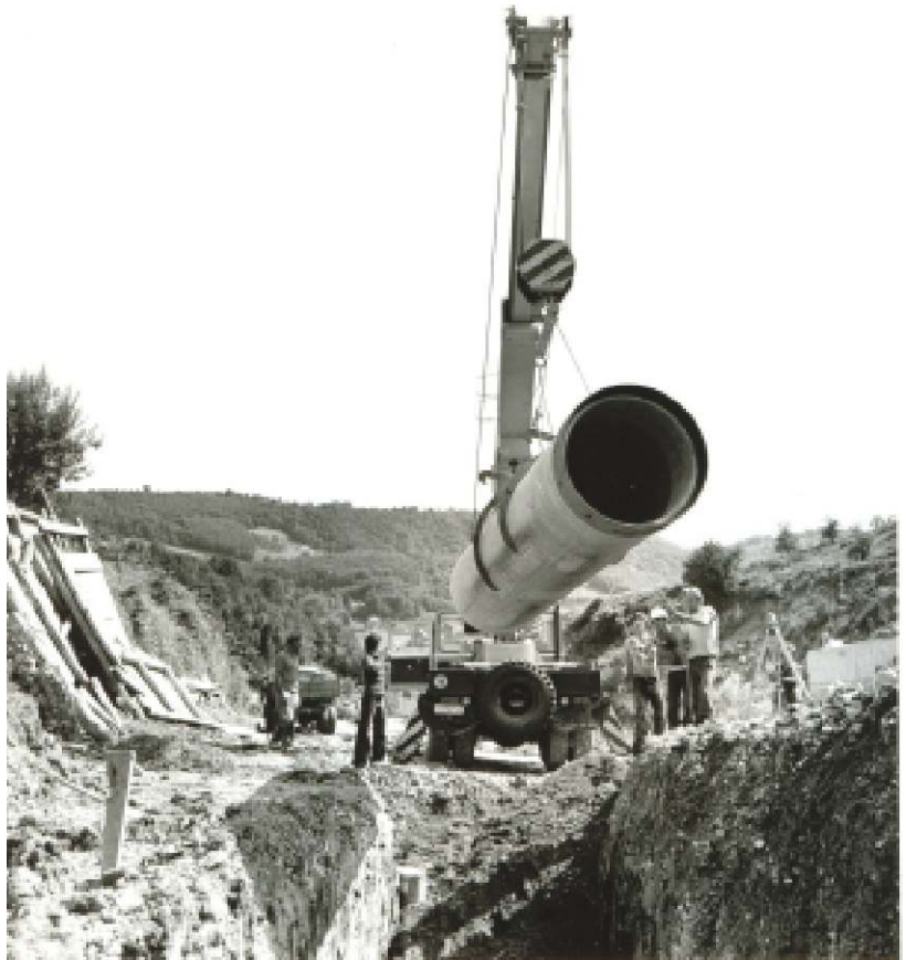
Изградња фекалног колектора до Севојна
