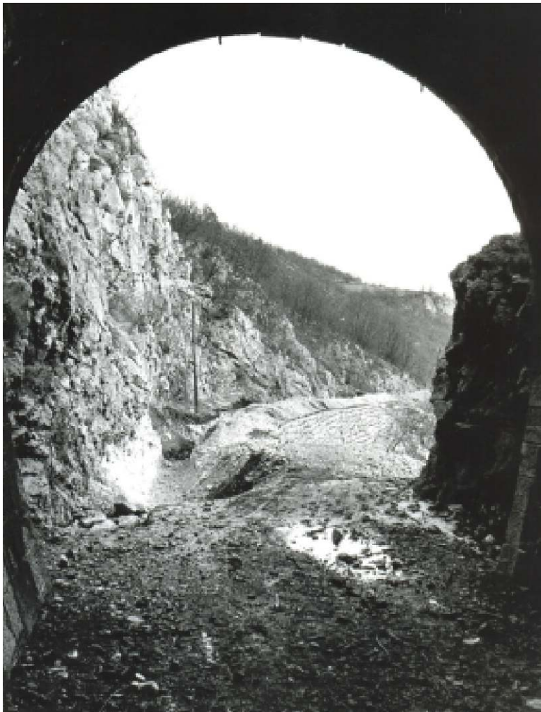
Траса старе пруге узаног колосека коришћена је за полагање цевовода сирове воде
