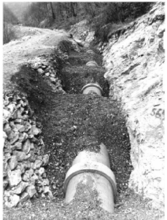
Цевовод сирове воде (АЦЦ Ø 700)
