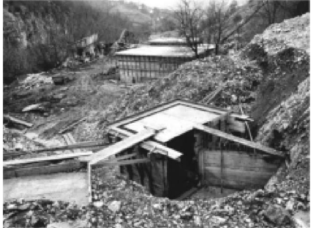
Изградња постројења у Поточању
