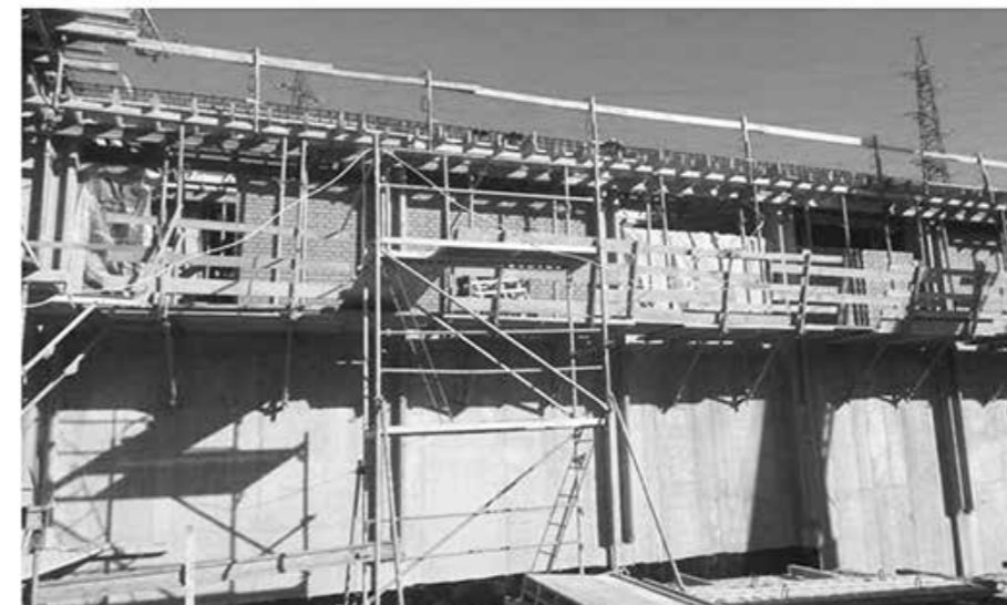
Грађевински радови објекта за флокулацију у завршној фази
