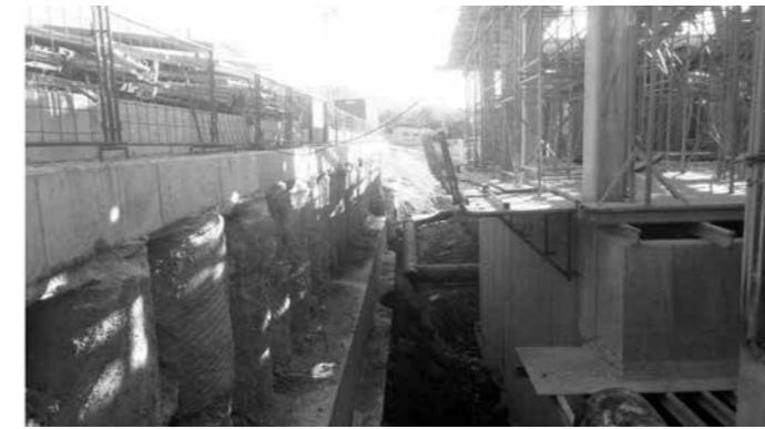
Шийови за заштитну ископа и објект за озонизацију – простор између објекта се пуни земљом до врха шийова
